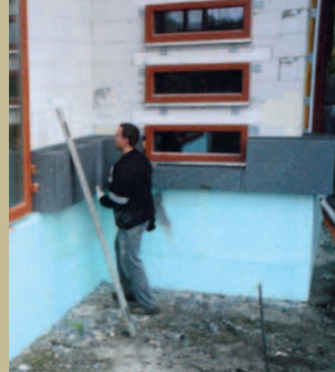
Ezen a passívházon az alaptest alá és köré alkalmazott teherbíró, vízálló XPS (kék), a felmenő falazatra erősített grafitos EPS (szürke) és a tetősíkba fektetett táblás PUR (sárga) hőszigetelés alkotja a hőhídmentes „termikus burkot”.
