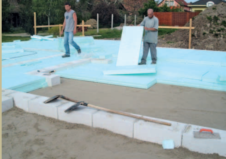
Ezen a passívházon az alaptest alá és köré alkalmazott teherbíró, vízálló XPS (kék), a felmenő falazatra erősített grafitos EPS (szürke) és a tetősíkba fektetett táblás PUR (sárga) hőszigetelés alkotja a hőhídmentes „termikus burkot”.
