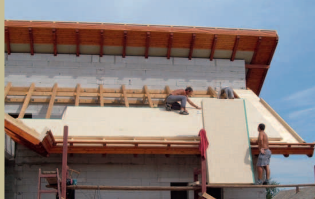
Ezen a passívházon az alaptest alá és köré alkalmazott teherbíró, vízálló XPS (kék), a felmenő falazatra erősített grafitos EPS (szürke) és a tetősíkba fektetett táblás PUR (sárga) hőszigetelés alkotja a hőhídmentes „termikus burkot”.
