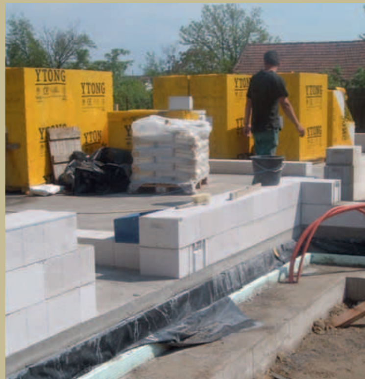
Ezen a passívházon az alaptest alá és köré alkalmazott teherbíró, vízálló XPS (kék), a felmenő falazatra erősített grafitos EPS (szürke) és a tetősíkba fektetett táblás PUR (sárga) hőszigetelés alkotja a hőhídmentes „termikus burkot”.
